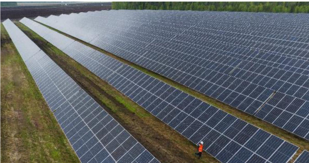
Kuva 5. Paneelirivistöjen välissä mahtuu ajamaan mönkijällä tms. maastokelpoisella ajoneuvolla.
