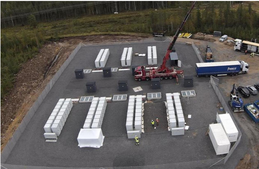
Kuva 7. Kuvituskuva: Akkujärjestelmä rakentuu (Kuva: Kauppalehti)
