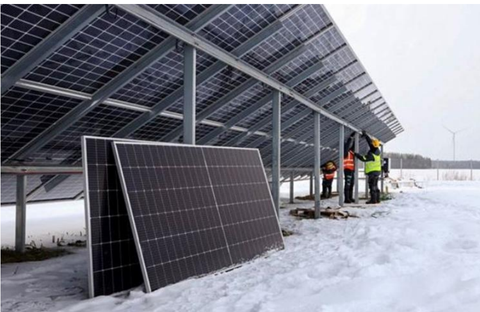
Kuva 6. Paneelit asennetaan 30 asteen kulmaan (kuva Helsingin Sanomat)
