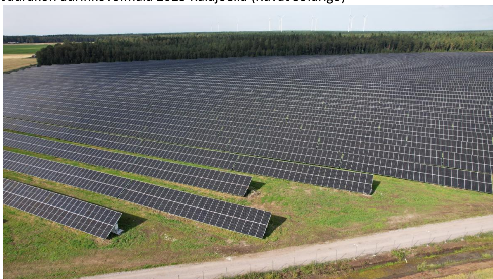
Kuva 3. Paneelirivistöt etelän suuntaan.
